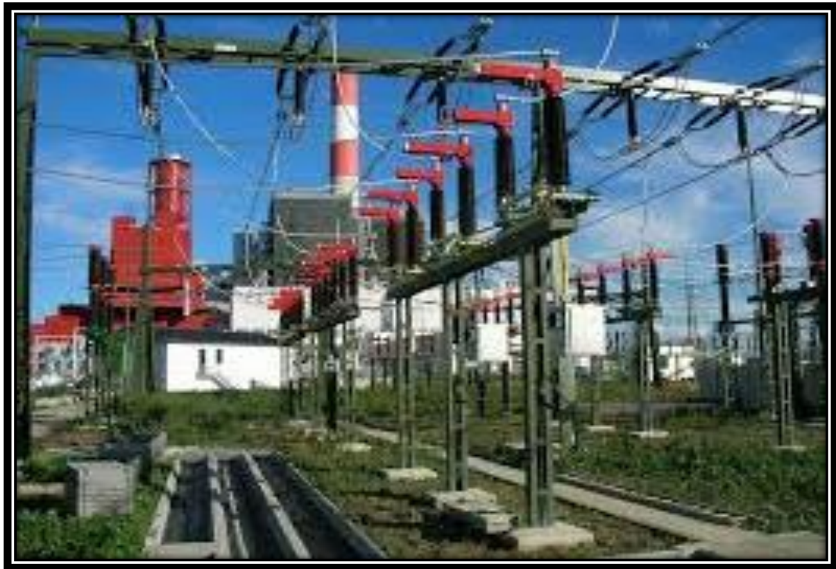
نمونه ای از پست AIS و تجهیزات آن
