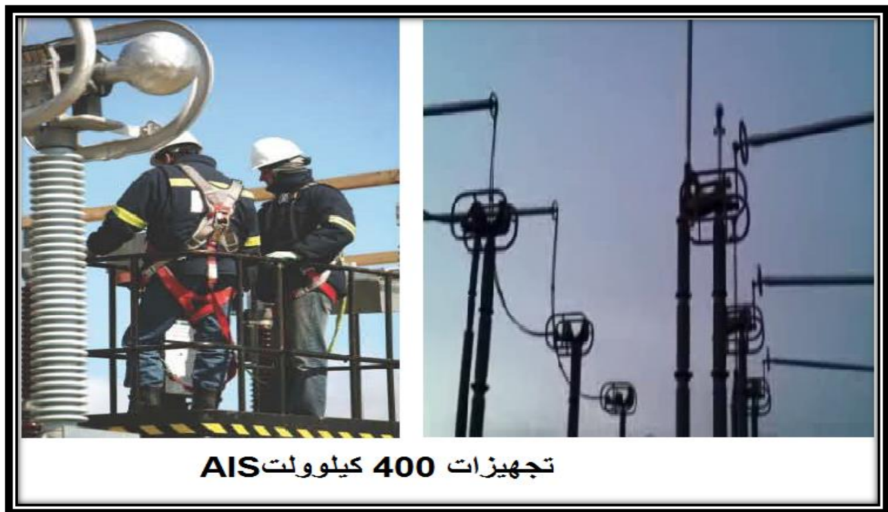
نمونه ای از پست AIS و تجهیزات آن
